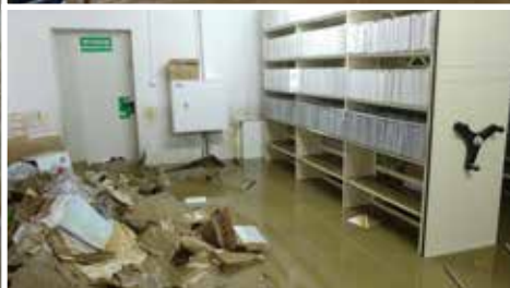
Zalane pomieszczenia w budynkach Państwowej Akademii Nauk Stosowanych w Nysie
