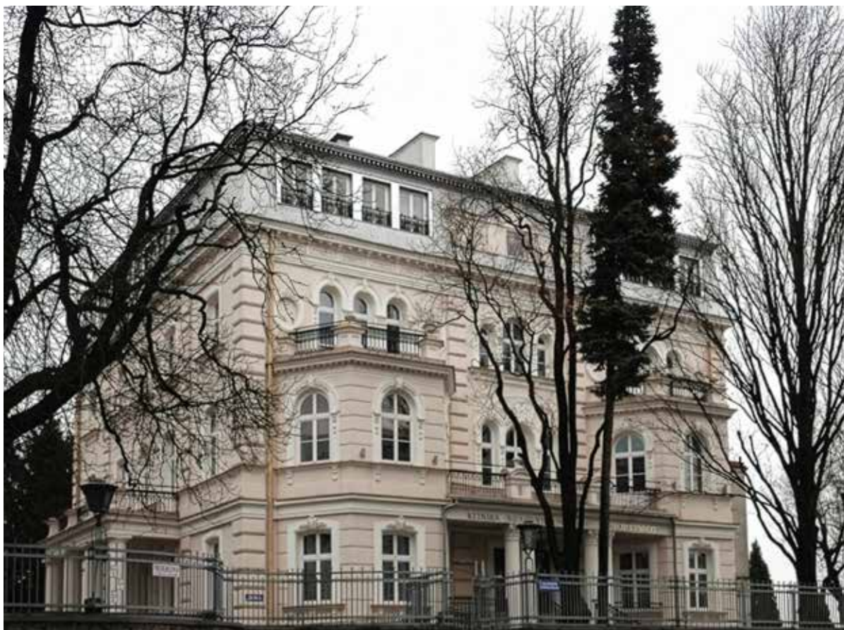
Budynek Kliniki Okulistycznej przy ul. Chmielnej w Lublinie Źródło: klinikaokulistyki.umlub.pl
