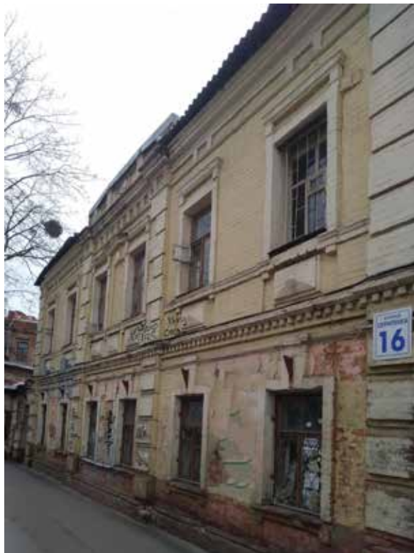
Budynek przy zaułku Sediukowskim 4 (obecnie ulica Mykoły Skrypnyka 16), w którym mieszkała rodzina Szareckich. Fot. Lubow Żwanko
