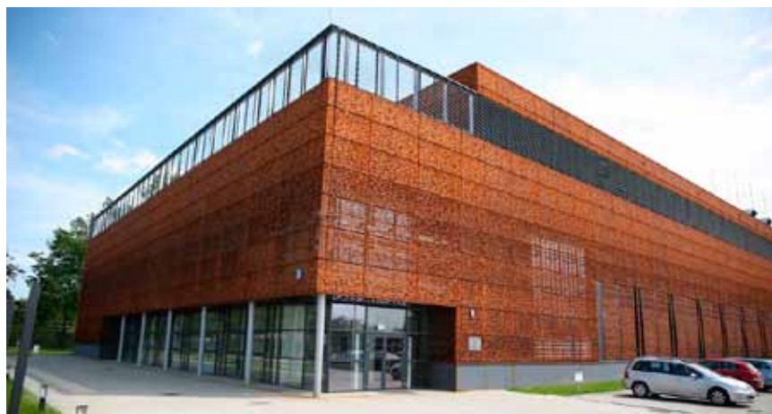
Centrum Technologii (serwerownia) ICM
