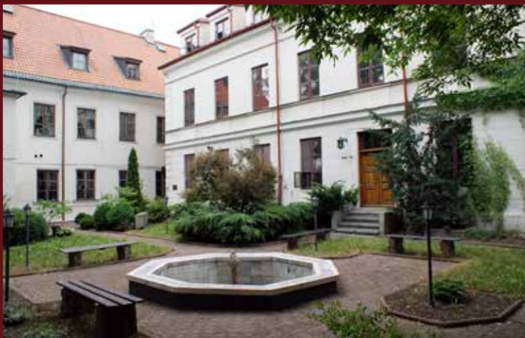
Siedziba Towarzystwa Naukowego Płockiego od strony ogrodu – kamienica z XV wieku (skrzydło po lewej) wraz z XIX-wieczną oficyną (skrzydło po prawej)
