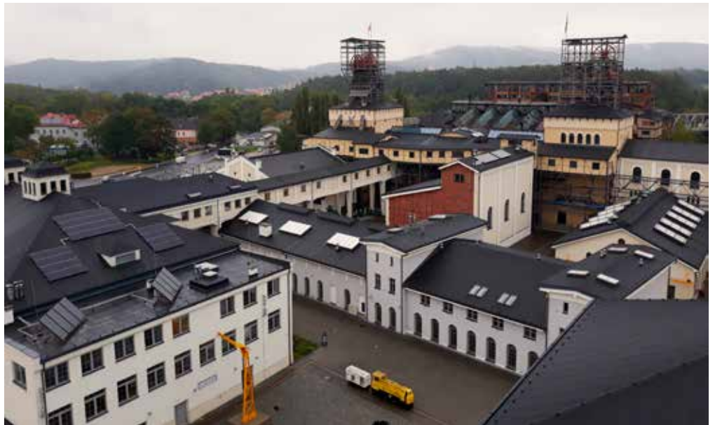
Wałbrzych, widok z wieży na terenie Centrum Stara Kopalnia
